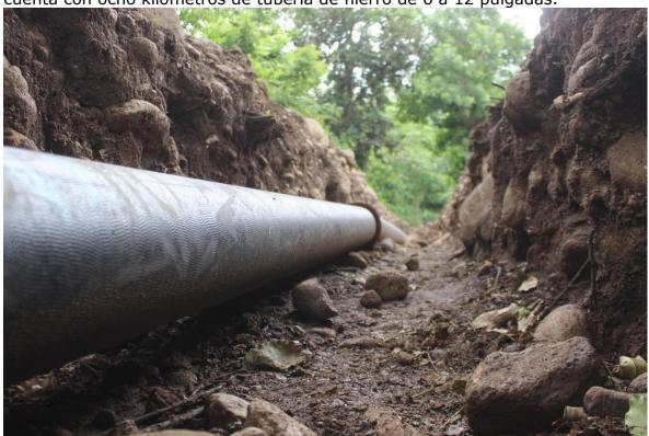
"La obra fue diseñada con una captación de agua tipo presa de 12 metros de ancho por 2.5 metros de alto, a través de un tubo de 10 pulgadas hacia el desarenador, construyendo dos tanques rompecabezas, generando 450 galones de agua por minuto", detalló García.
