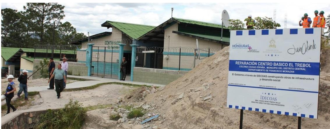
Por su parte el ministro del IDECOAS, Nelson Márquez, detalló que el proyecto consiste en la reparación de 16 aulas, muro perimetral, sistema de aguas lluvias y dos módulos sanitarios.
